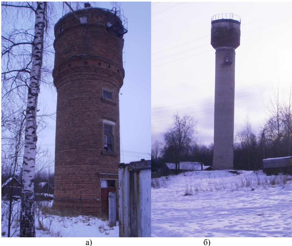
Рис. 1.1 Водонапорная башня в пос. Сельхозтехника (а), водонапорная башня в дер.Мозолево-1(б),
