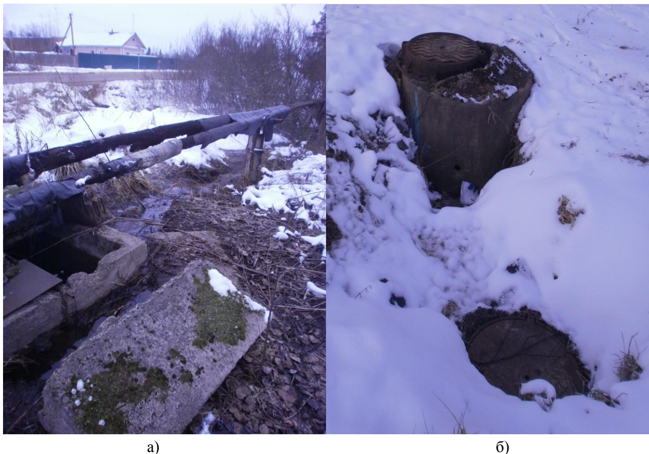
Рис. 1.2 Водопроводные сети пос. Сельхозтехника (а), смотровой колодец дер.Мозолево-1(б)
